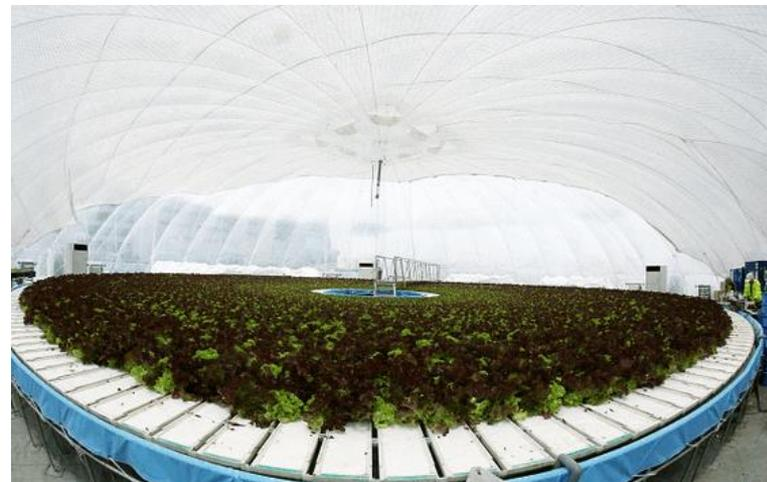
Поворотный механизм в бассейне купольных теплиц японской Granpa Co., Ltd. сложный и дорогой, а надувной (D27м) купол не рассчитан на нашу снеговую нагрузку. Цена комплекта 325 тысяч евро + таможня + доставка + монтаж + программное обеспечение.
