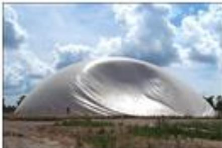
**Знакопеременные** нагрузки – собственный вес, ветровые, снеговые, ударные – у купола незначительны на кольцевом фундаменте, нагрузка на грунт не превышает 1кг/кв.см. Это позволяет уйти от массивных и дорогих фундаментов.
