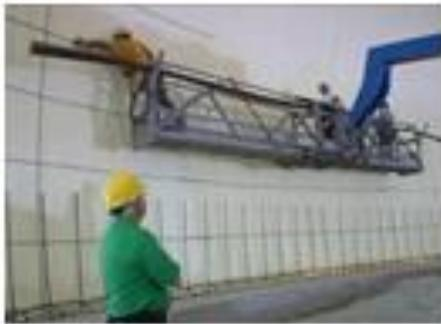
**Напыление** из ППУ образует ровный монолитный слой на поверхности мембраны, тут нет мостиков холода, даже крепеж арматуры ППУ плотно облегает по поверхности.
