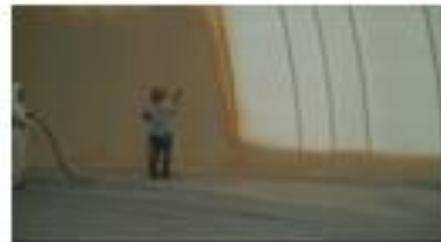
**Пневмокаркас** купола готовят для основательного крепления по периметру фундамента, чтобы форму можно было накачать воздухом.
