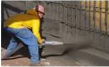
**Арматура** завозится до наполнения мембраны воздухом, вместе с оборудованием. Горизонтальное и вертикальное армирование производится в геометрически правильных пропорциях, что создает прочную арматурную сетку.
