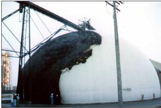
В НЕПОСРЕДСТВЕННОЙ БЛИЗОСТИ ОТ ЭТОГО ХРАНИЛИЩА ГОРЮЧИХ УДОБРЕНИЙ ПРОИЗОШЕЛ ВЗРЫВ ТРАНСФОРМАТОРНОЙ ПОДСТАНЦИИ С ВЫБРОСОМ 900 ЛИТРОВ МАСЛА. БЫЛ ПОВРЕЖДЕН ТОЛЬКО УТЕПЛИТЕЛЬ И ПВХ, КОТОРЫЙ ОТРЕМОНТИРОВАЛИ В ТЕЧЕНИЕ 1-Й НЕДЕЛИ.
