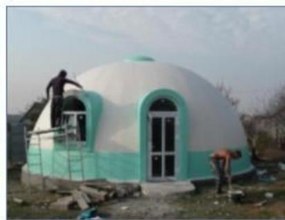
На подготовленный фундамент монтируется сфера из отдельных элементов по поясам. Элементы каждого пояса имеют свои типоразмеры. Крепление элементов производится при помощи соединения по типу шип-паз и дополнительно проклеиваются монтажной пеной.
