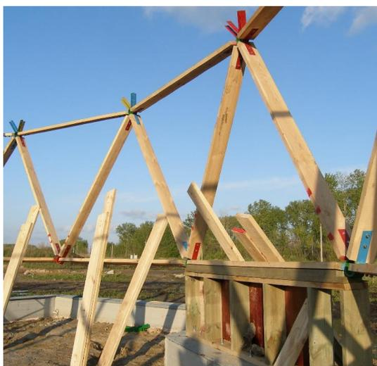
Но я не нашел информации о самом строящемся куполе. Никакой. Военная тайна, наверное. Кроме не подписанных фото строящегося купола – по конструкции геодезического, на самопальных, необработанных, стальных коннекторах - 3V, h5/8, R8м, со стенкой 0,7м. на ленточном свайном незаглубленном фундаменте без «подушки» на весьма пучинистых водонасыщенных грунтах.
