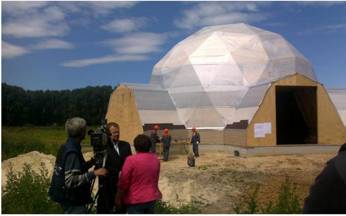
А в Тюмени ребра купола видимо 40мм x 180мм, что весьма недостаточно для устройства надлежащей теплозащиты ограждающего каркаса. На фото нет работ по утеплению каркаса.
