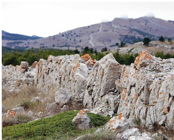
**СНЕГОЗАДЕРЖАТЕЛЬНАЯ СТЕНА.** Элемент единственной в мире системы водосбора, построенной на яйле
