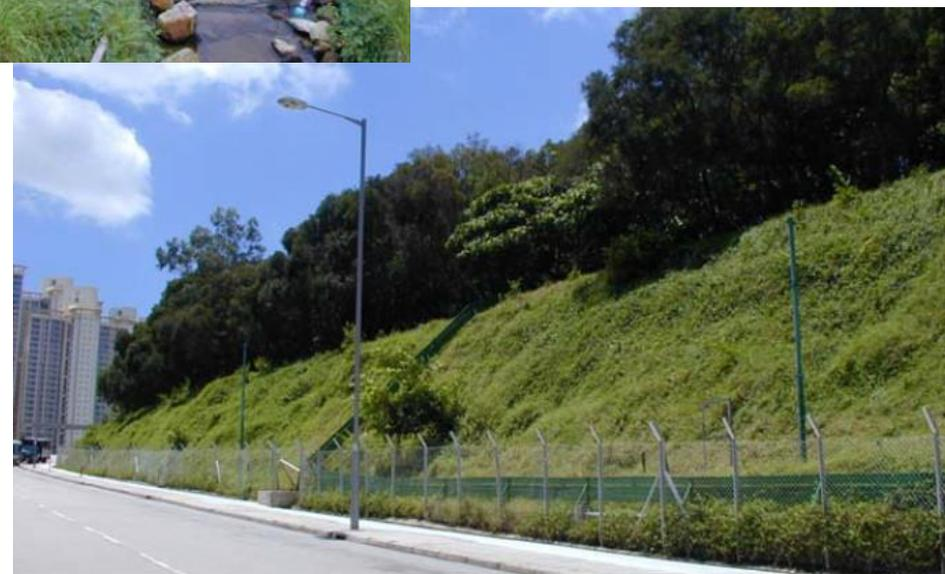
*При маленьких и средних уклонах – до 8% склоны укрепляют растениями вертикального и горизонтального действия, а также деревьями, которые можно высадить в ячейках специальных укрепляющих конструкций.*
